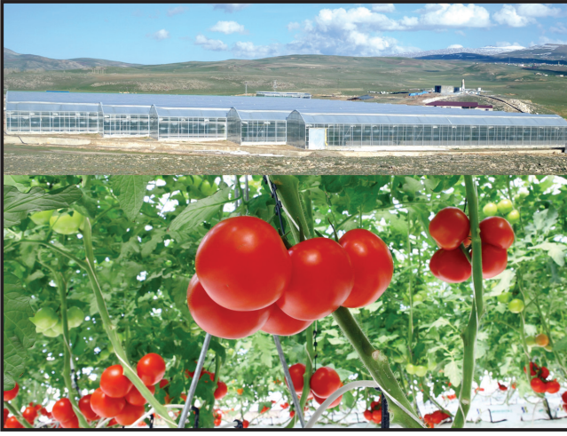
Şekil 7- B) Ağrı-Diyadin jeotermal sahasında sera uygulaması (7)
