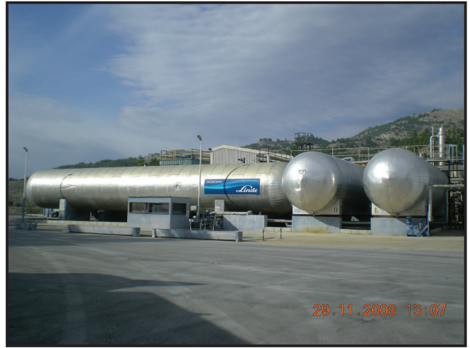
Şekil 11: Kızıldere sahasında yan ürün olarak CO 2 üretimi
